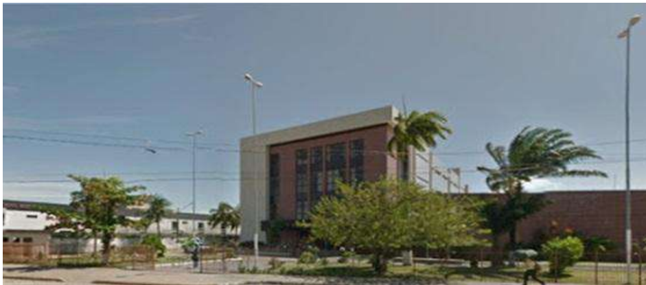
Fig.1: Fórum Lourenço José Ribeiro front view.
