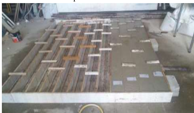
Fig.3: Enchimento das capas das vigotas pré-moldadas
