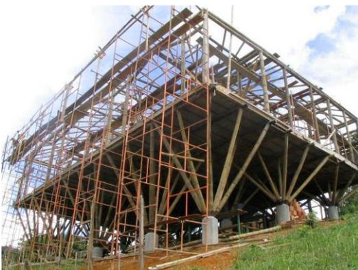
*Fig.7: Casa estruturada com bambu*
