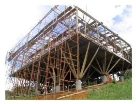
Fig.7: Casa estruturada com bambu Fonte:Oliveira (2013).
