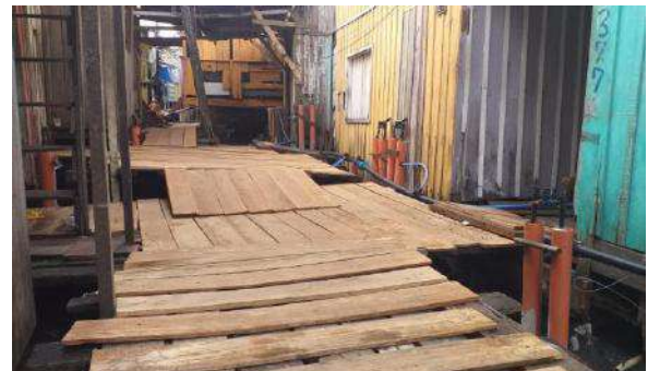
Fig. 7: Medidores (hidrômetros) instalados em palafitas
